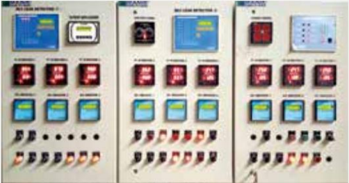
Bảng điều khiển tự động hóa phòng lạnh
